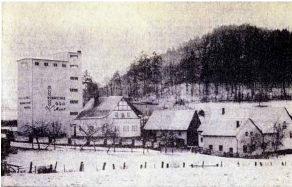
Die Hünnicher Mühle bei Polle mit dem neuen Getreidesilo
