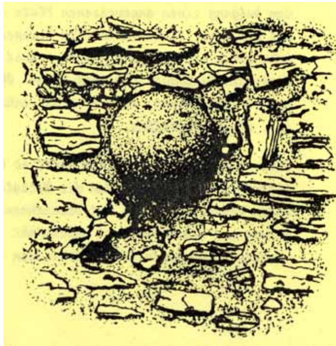
Kanonenkugel im Bruchsteinmauerwerk
