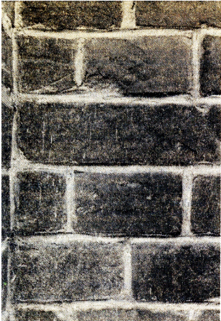
Handgestellter Ziegelstein mit Fingerabdrücken, gesehen am ehemaligen Bickerschen Hof in der Pyrmonter Straße
