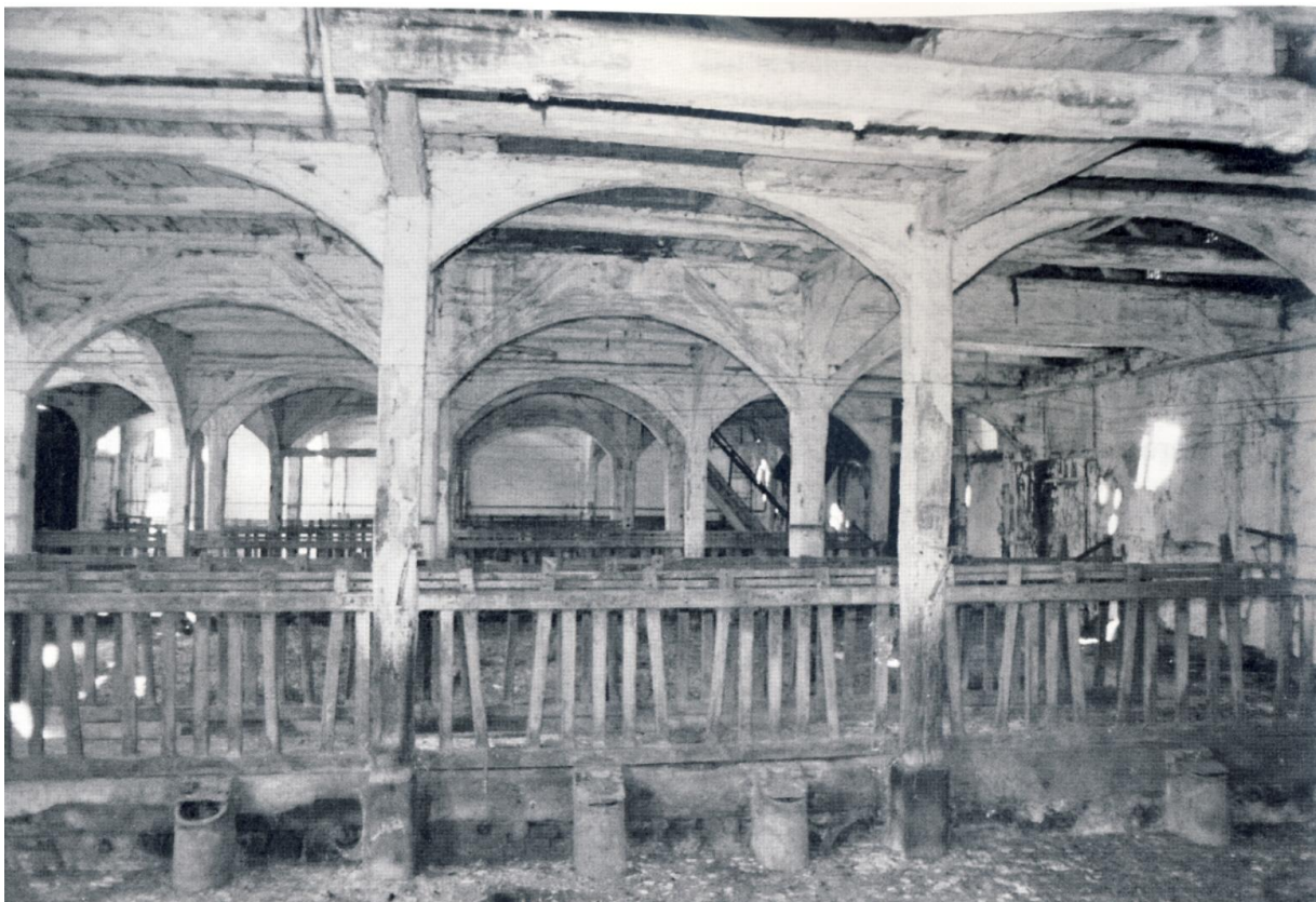
Abb. 7: Mittel-Längsdurchschnitt durch den alten Rinderstall mit seiner einmaligen Bogenarchitektur. (Foto: Dietrich Maschmeyer).
