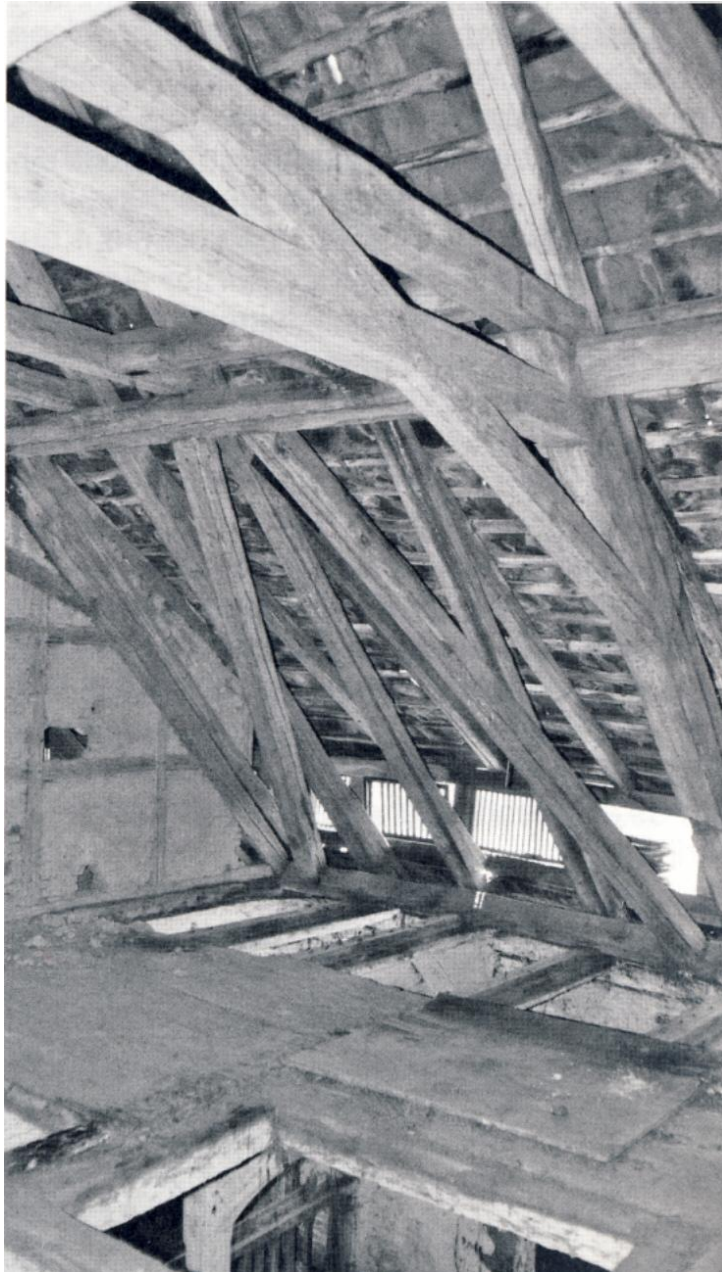
Abb. 8: Der Dachstuhl weicht deutlich von denen der anderen Gebäude ab und wurde möglicherweise von auswärtigen Zimmerern ausgeführt (Foto: Dietrich Maschmeyer)-
