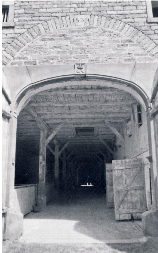
Abb. 4: Tor des jüngeren Schafstalles von 1839: Werksteingewände mit Königskrone und Initialien E(rnst) A(ugust) und Datierung auf dem Schlussstein des Entlastungsbogen darüber – und damit nebenbei ein frühes Beispiel für „materialgerechtes“, bewusst unverputzt gelassenes Sichtmauerwerk.
